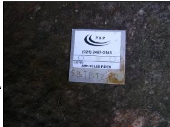
Marco topográfico de georeferenciamento da usina Teles Pires.
