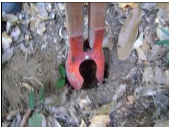
Uso de cavadeira articulada para abertura de poço teste.
